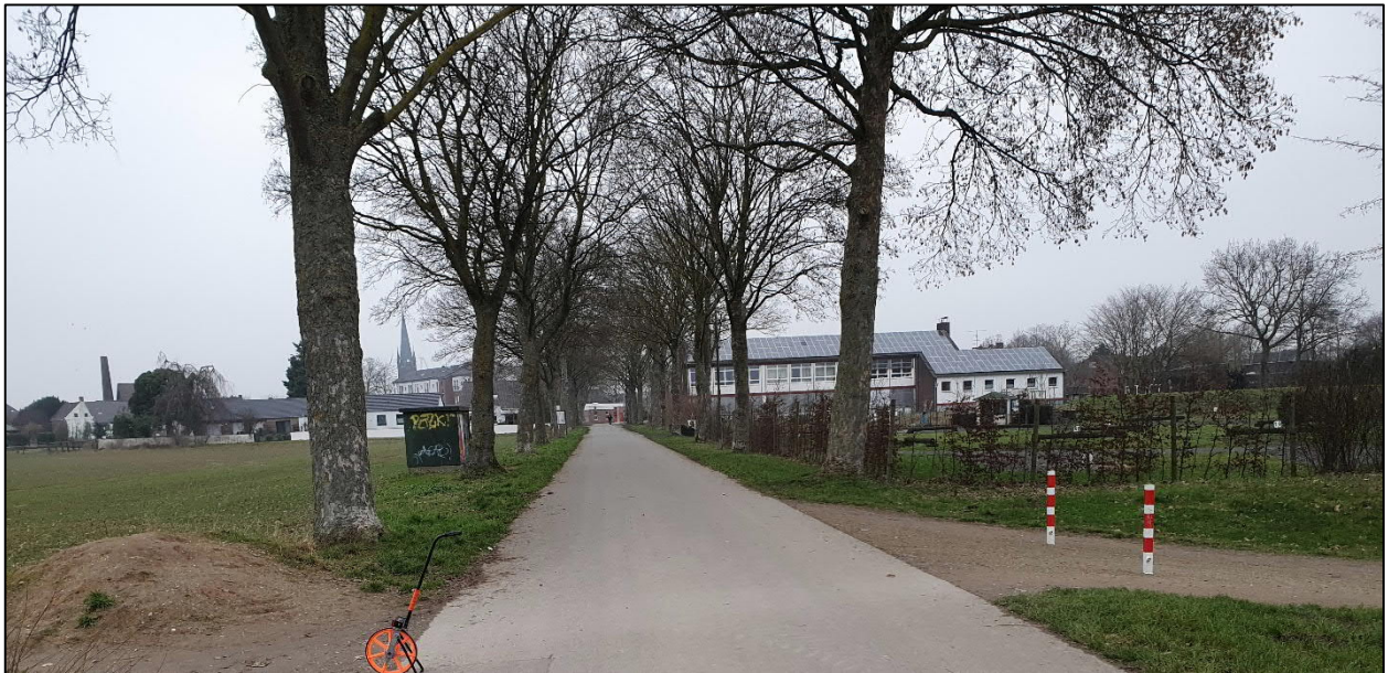
Abbildung 4: Kempener Straße in Höhe „Aldekerk Park“, Blickrichtung Norden
