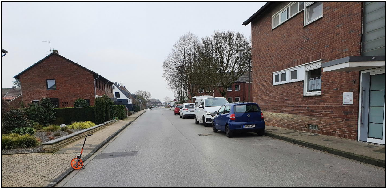
Abbildung 11: Rahmer Kirchweg südöstlich Kempener Straße, Blickrichtung Südosten
